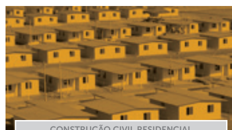
CONSTRUÇÃO CIVIL RESIDENCIAL
